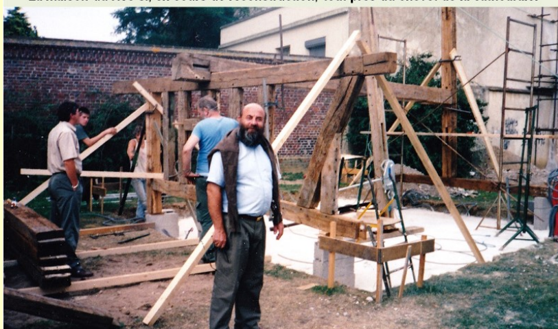
La maison du XVe s., en cours de reconstruction, tout près du chevet de la cathédrale.
